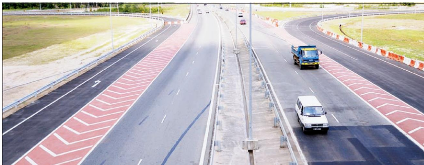
PEMANDANGAN keadaan Lebuhraya Tutong-Telisai dari jambat yang menghubungkan ke kawasan Rancangan Perumahan Negara Bukit Beruang dan institusi pendidikan yang berdekatan yang telah dibuka rasmi.
